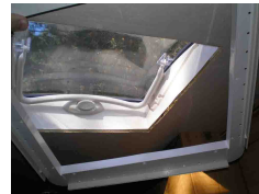
... el bastidor de anclaje.
