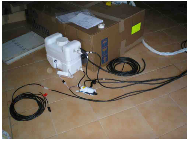
Vista general de todas las conexiones. La manguera blanca lleva 3 tubos de agua y 2 cables de conexionado
