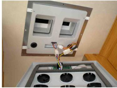
.... conectamos los conectores de la unidad del techo con la consola interior ...
