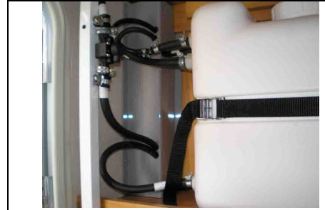
Conexiones definitivas. Saco los tubos por agujeros hechos en el carenado de la calefacción. Grifo de entrada de agua
