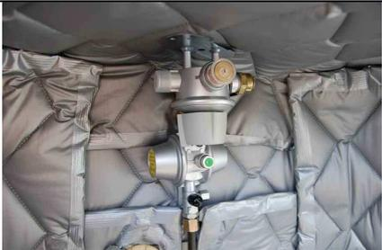
Y sobre el codo a 90°, atornillo el DuoConfort en horizontal
