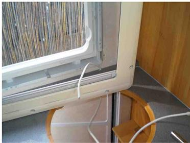
Se monta el bastidor del casete con la mosquitera y el oscurecedor, haciendo una muesca para que pase el cable
