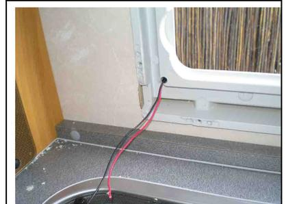
Cables por dentro de la ventana. La conexión ya la hemos visto en la sección de cableado. Se hace mediante macarrón termorretráctil
