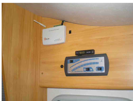
Vista general con todo ya montado
