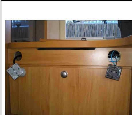
El enchufe izquierdo es original de la AC. El enchufe derecho lo instale con anterioridad conectado a un circuito que sale del ondulator. De ambos es de donde tomo la corriente para instalar los nuevos en el salón.
