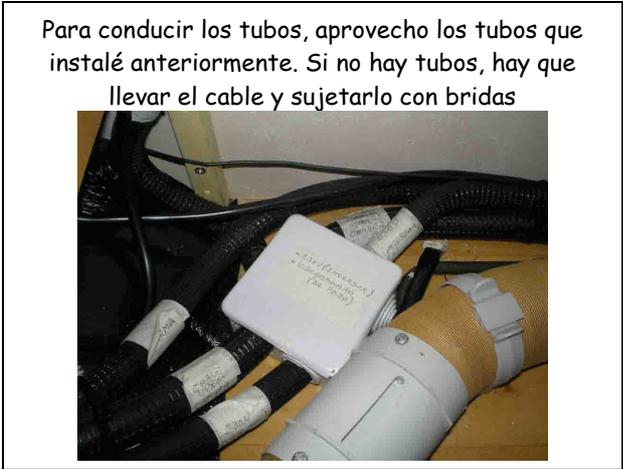
Para conducir los tubos, aprovecho los tubos que instalé anteriormente. Si no hay tubos, hay que llevar el cable y sujetarlo con bridas
