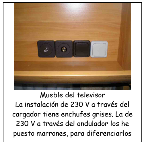
Vista general del enchufe montado. Es el marrón de la derecha.
