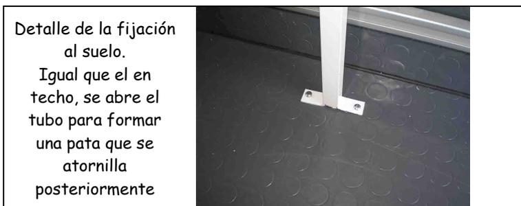
Detalle de la fijación al suelo. Igual que el en techo, se abre el tubo para formar una pata que se atornilla posteriormente
