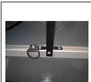
Detalle de la sujeción de los tubos a la base
